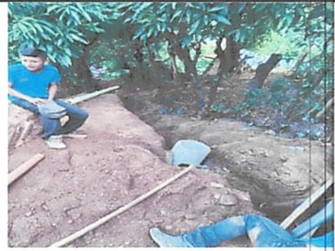
Foto 6: Instalación de drenaje.
