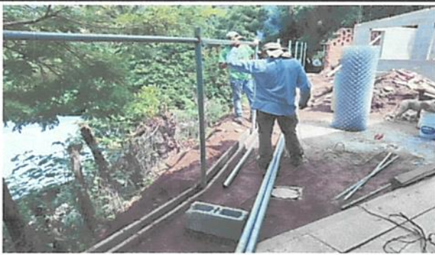
Foto 5: Instalación muro de maya.
