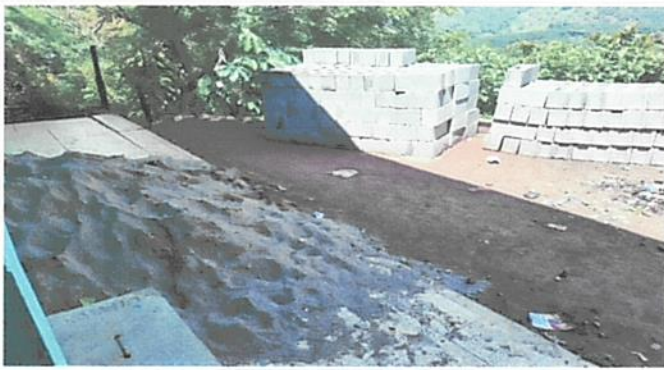
Foto 1: Material en la escuela para dar inicio.
