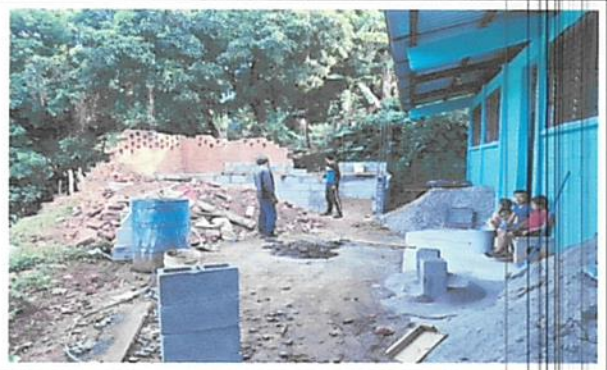
Foto 2: Inicio de construcción de cocina.
